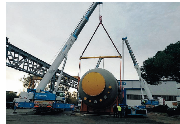
LE GRU Tre quelle impiegate per sollevare il serbatoio
