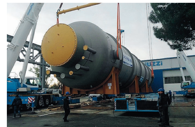
LE GRU Tre quelle impiegate per sollevare il serbatoio
